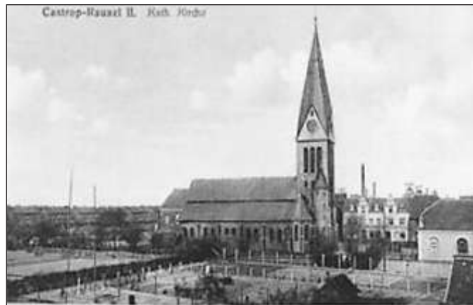
Die Herz Jesu Kirche mit dem weithin sichtbaren Kirchturm. Rechts im Hintergrund die Fördertürme der Zeche Victor 1/2.
